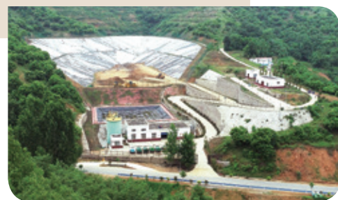
南陽收運及處理項目基地
