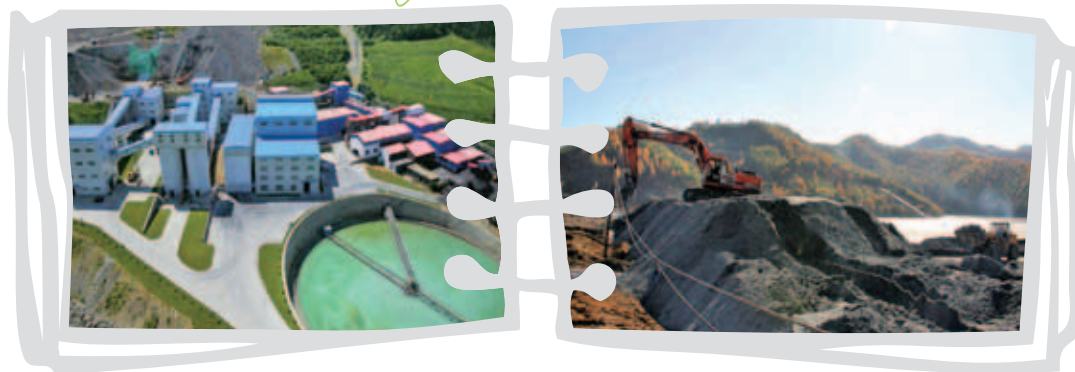
圖片右下角為傲牛鐵礦尾礦漿濃縮及溢流水循環利用系統的濃密池
