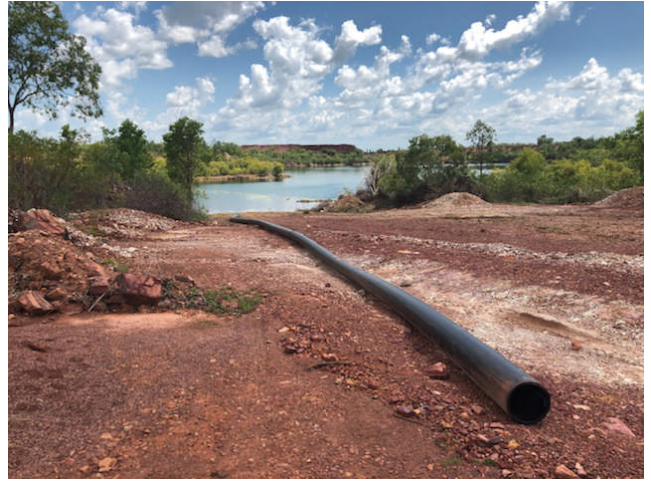
圖五：旗艦項目Rustlers Roost露天礦坑安裝的排水系統
