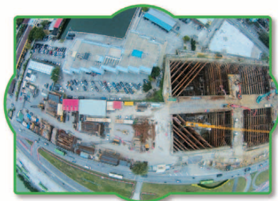
澳門媽閣交通樞紐建造工程
