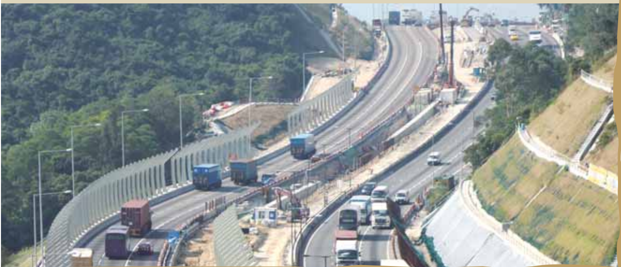
屯門公路重建改善工程－大欖段
