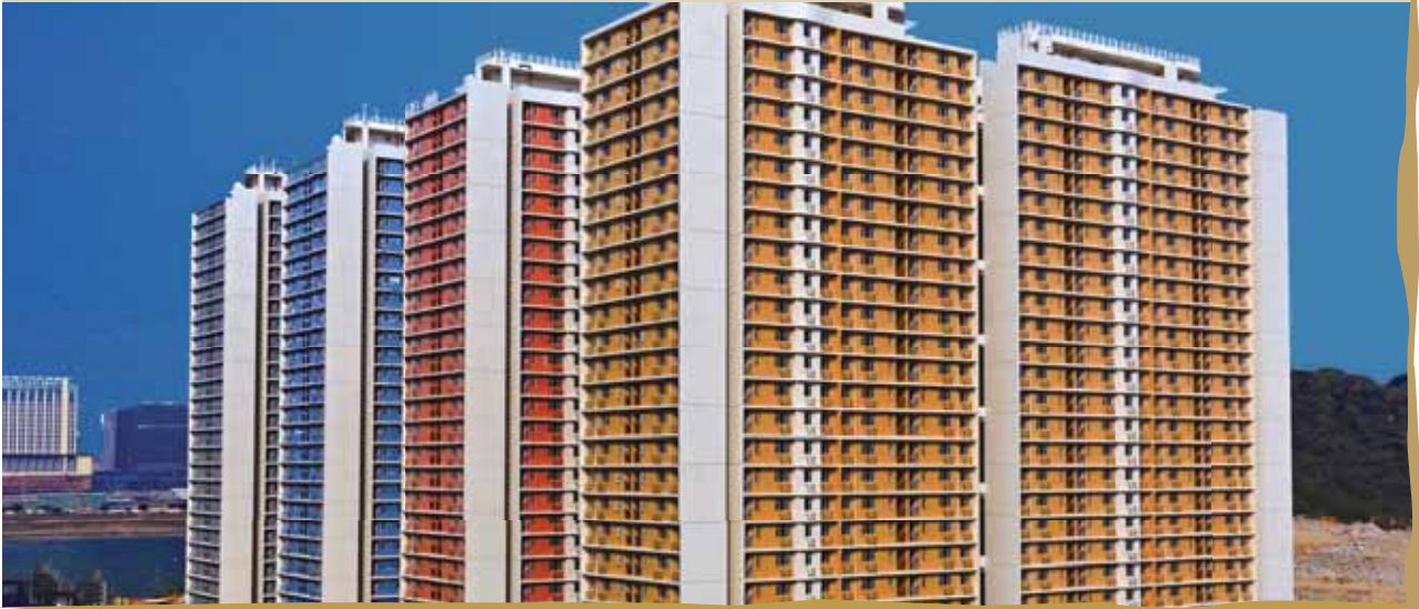
石排灣公共房屋CN5a地段工程
