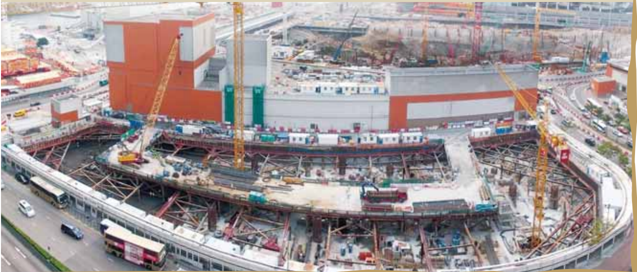
九龍柯士甸站KIL11129地段住宅上蓋發展項目Site D
