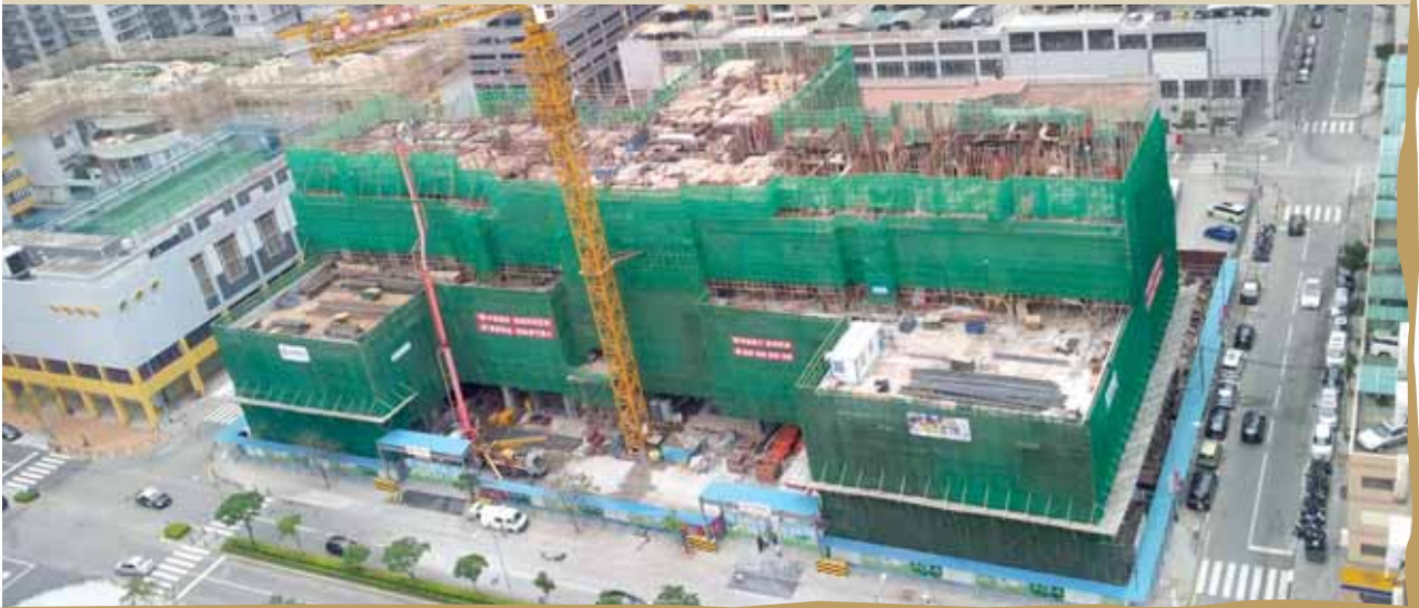
氹仔濠景四期上蓋建造工程
