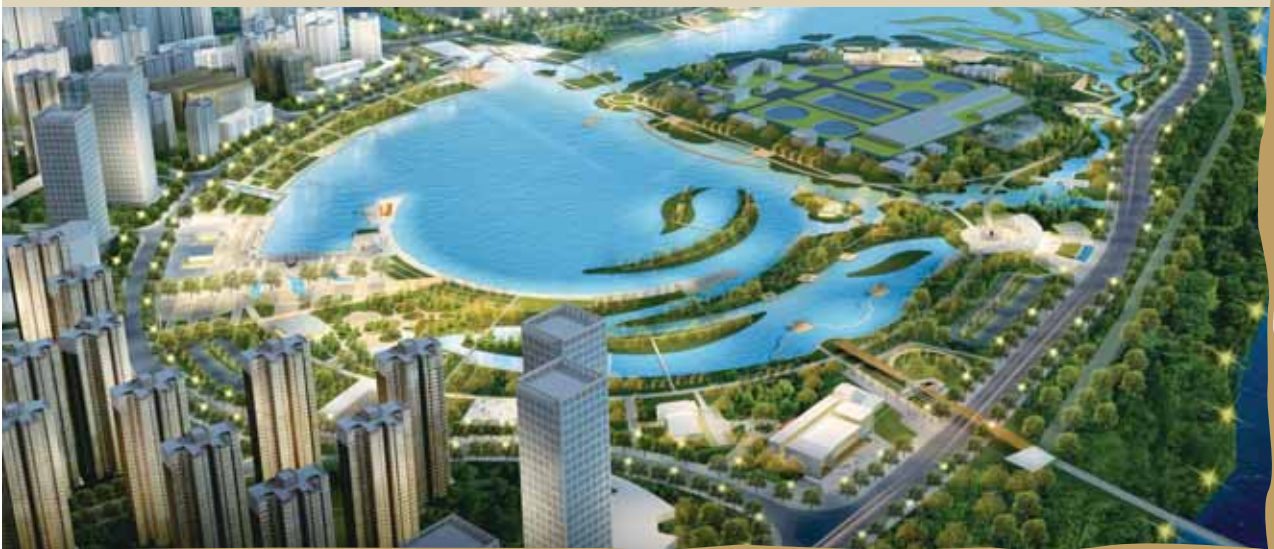
漳州碧湖生態園基礎設施及安置房
