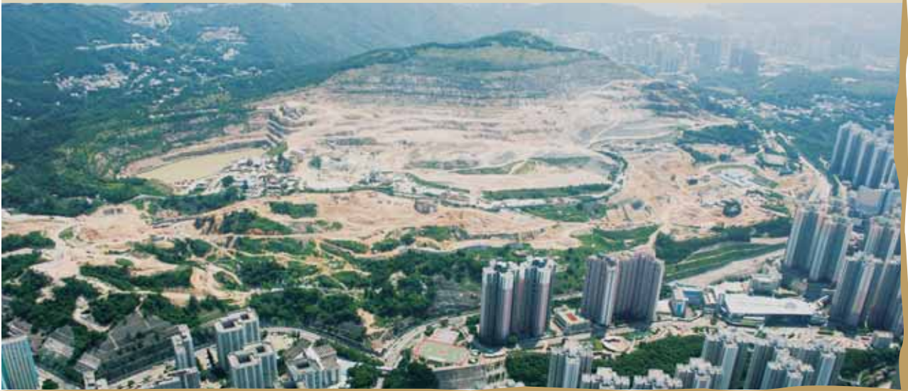
安達臣道地盤平整及基建工程
