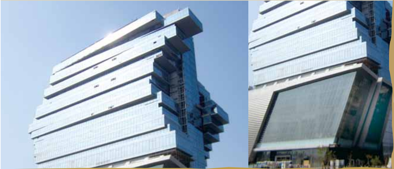
廣州市琶洲PZB1401項目管理總承包工程
