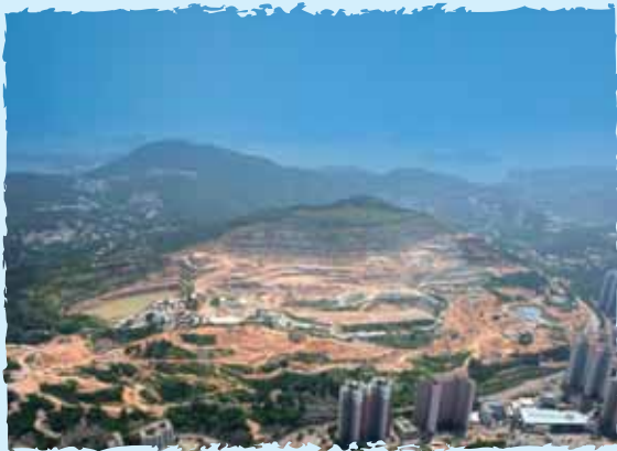
安達臣道地盤平整及基建工程
