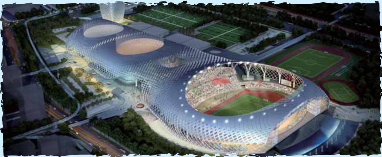
深圳灣體育中心工程項目
