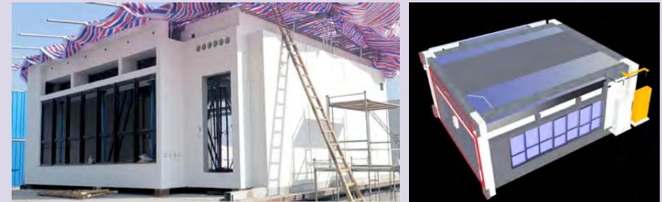
集團致力推廣MiC技術應用到更多建築項目，例如在香港和深圳承建的公立學校工程中，加入MiC建築元素。位於香港觀塘的安達臣道發展區中學項目，是香港建築署第一項學校工程使用MiC的試點項目。相關建築部份構件單元的結構、機電和裝修，如木櫃和鋁窗等，均在廠房預先完成製作，送達工地後吊運裝嵌。此先導計劃並確立了相關的項目規範，可用於將來同類MiC建築的設計、施工檢查、驗收，同時引入有關技術作為內地廠房出廠驗收的專業指引。
