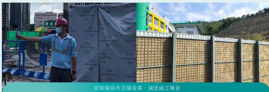
安裝隔音布及隔音屏，減低施工噪音
