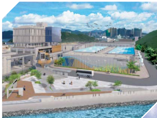
將軍澳海水化淡廠工程
