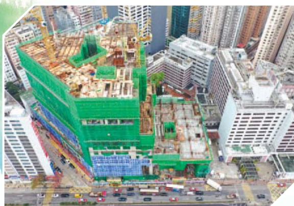
廣華醫院重建項目 第一期上蓋工程
