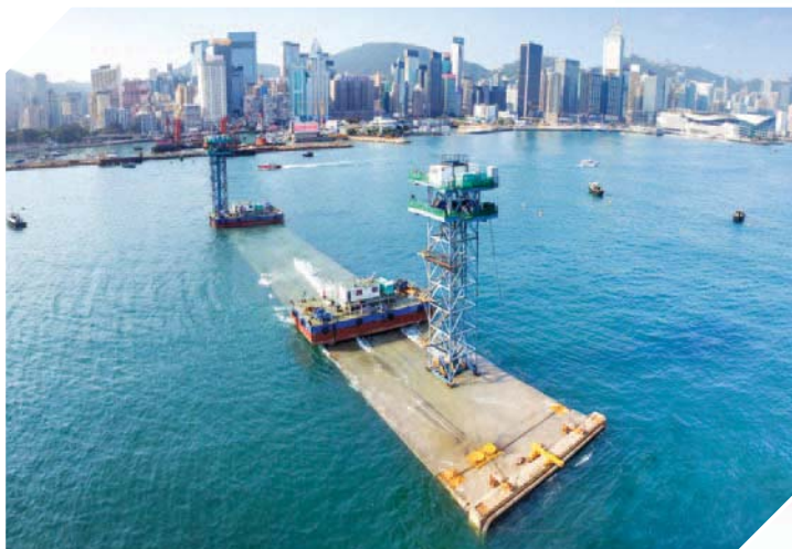
沙中線南北走廊過海 鐵路隧道建造工程
