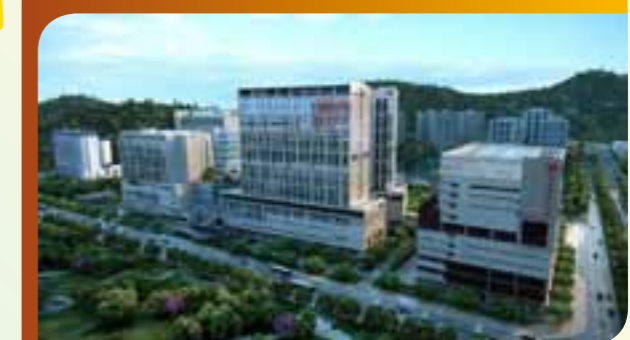
離島醫療綜合體主體建造工程
