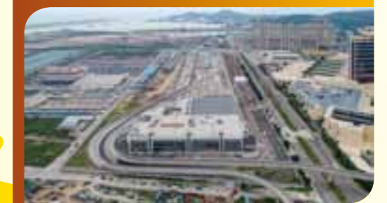
C385R – 輕軌車廠上蓋建造工程
