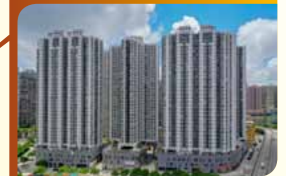
青洲坊公共房屋第 1 及第 2 地段建造工程
