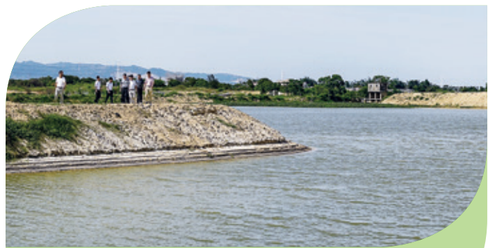
修建後 — 完成蓄水
