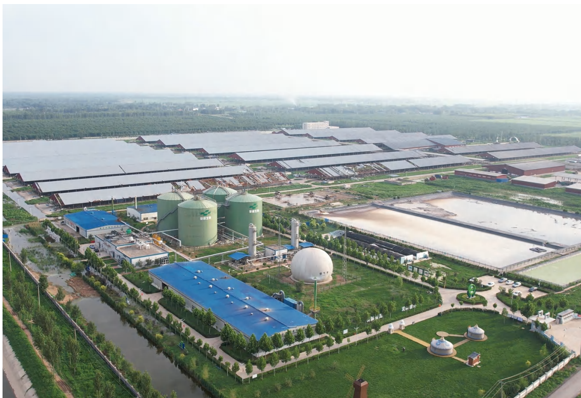
蒙牛旗下現代牧業糞污處理設施
