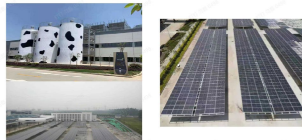
蒙牛武漢工廠光伏板發電
