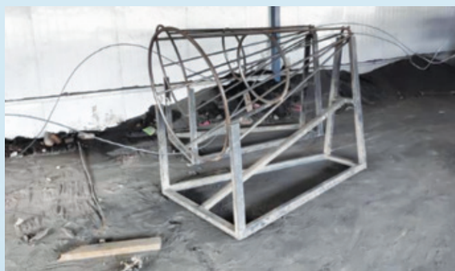
鋼筋調直防護
