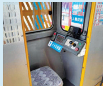
施工電梯司機人臉認別系統
