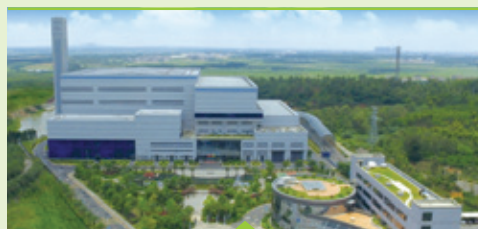
湛江垃圾焚燒發電廠
