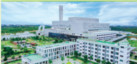
電白垃圾焚燒發電廠
