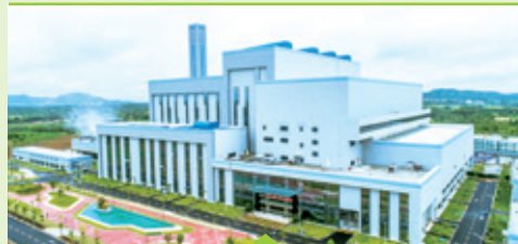
陸豐垃圾焚燒發電廠
