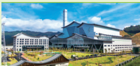
清遠垃圾焚燒發電廠
