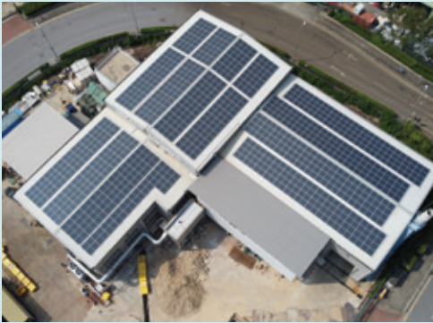
屯門香港電池回收中心屋頂光伏項目
