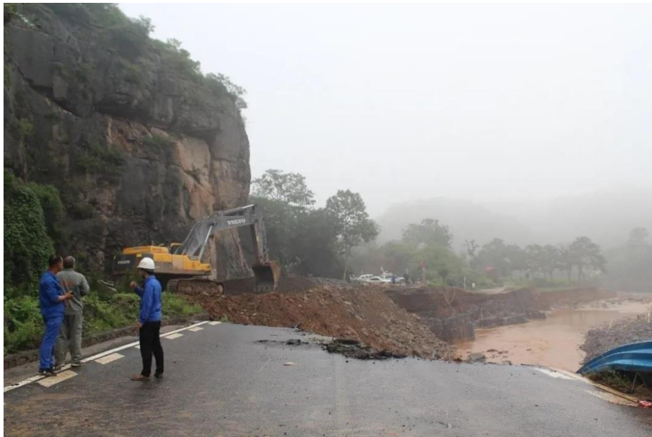
本集團出動挖掘機搶修 234 省道
