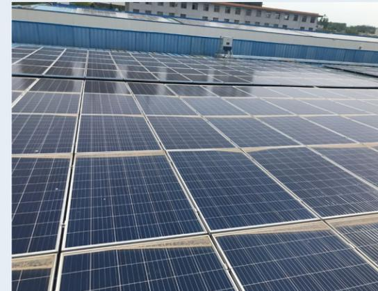
徐州核潤於組件廠頂部安裝太陽能發電設備，以生產可再生能源供其使用，減少因使用外購電力而產生的能源間接溫室氣體排放。於報告期內，徐州核潤使用了 794,760 千瓦時由太陽能光伏系統產生的電力，佔全組件廠用電量的 35%。
