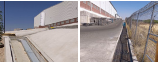
敏實墨西哥塗裝線雨水收集及回用
