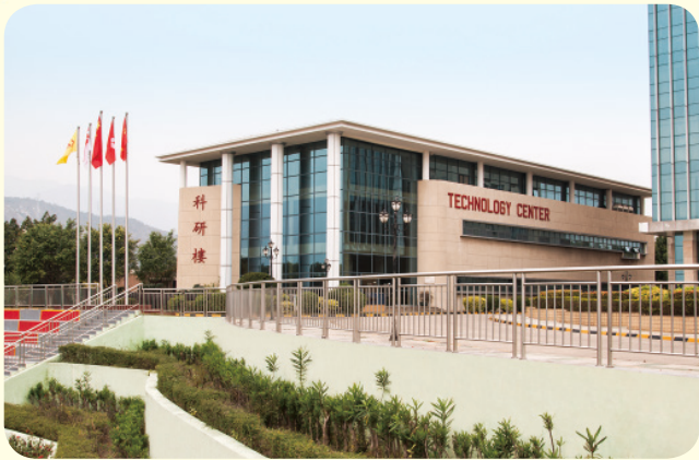
中國廣東省河源廠房科研樓一角
